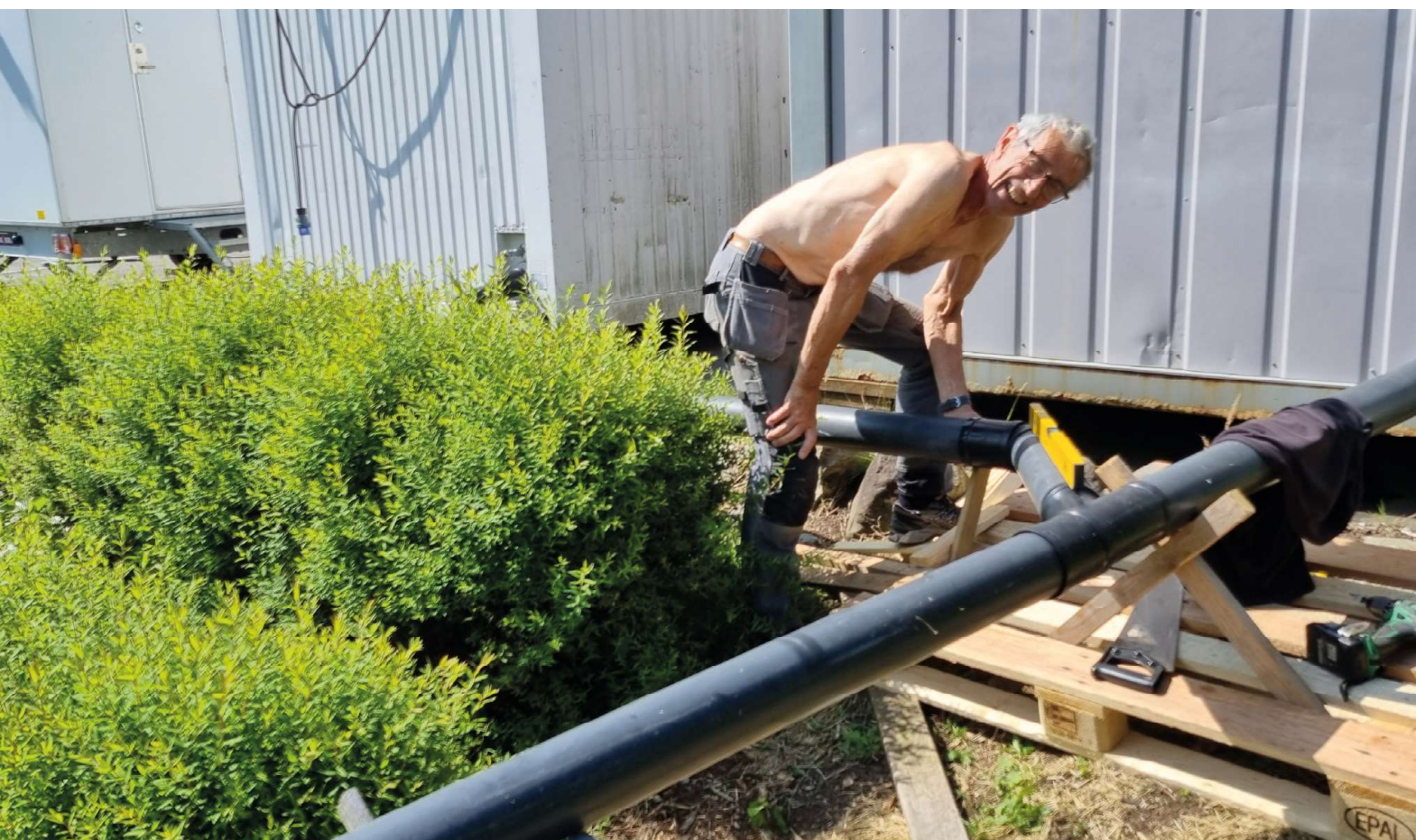
Jostein Idland monterer avløp til dusj og do-containerer.
